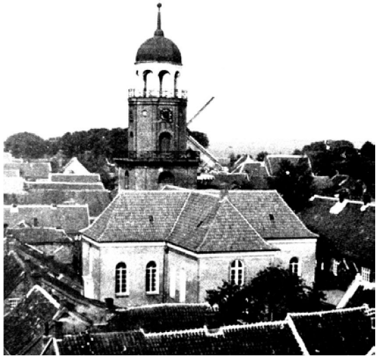
Die Kirche nach dem Neubau
