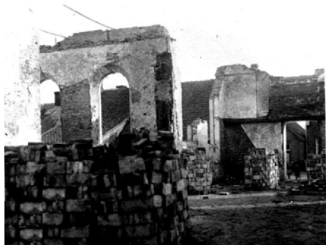
Schon bald wurden die Abbruchsteine für den Wiederaufbau gestapelt.
