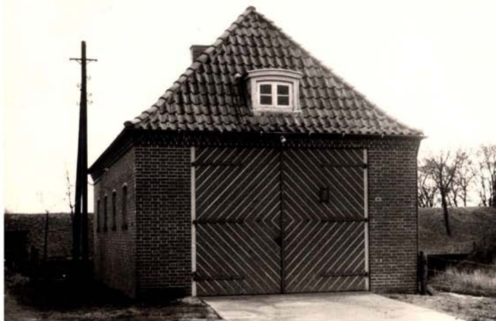
Gerätehaus der Freiwilligen Feuerwehr Jemgum
