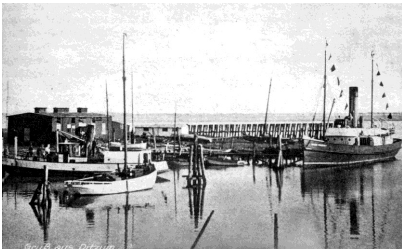
Der Hafen Ditzum um 1930: Im äußeren Hafenteil sind eine Garnelendarre und eine Schiffswerft gegründet worden. Den Abschluß des Hafens zur Ems hin bildet der Wellenbrecher. Im Vordergrund liegen ein Regierungsdampfer, das Fischereiaufsichtsboot und die Dampffähre Ditzum. Ansichtskarte im Besitz von L. Schröder, Ditzum
