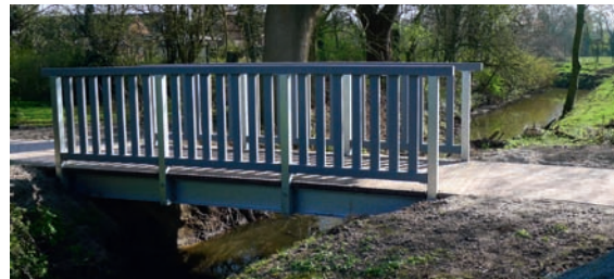
Die neue Brandschlootbrücke zwischen Lange Straße und Rathaus. Foto: G. Kronsweide
