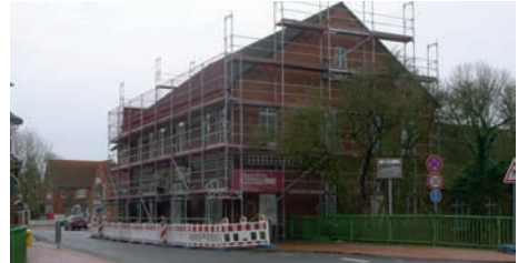
Der mit Baugerüsten umhüllte Jemgumer Hof. Foto: G. Kronsweide.
