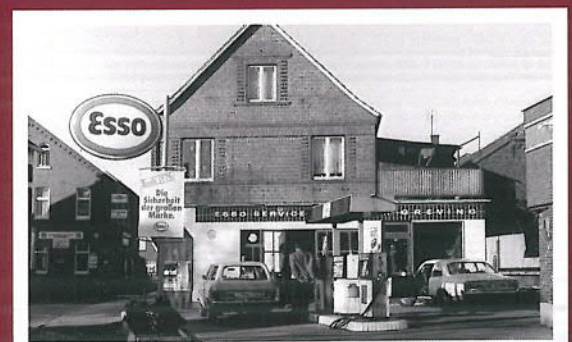
Aufnahme der Tankstelle Greving in Jemgum aus dem Jahr 1979.
