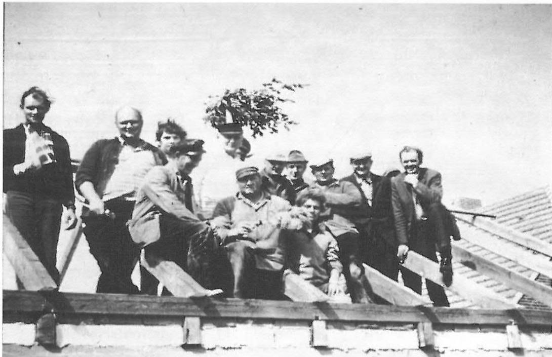
Richtfest des Feuerwehrhauses in Hatzum 1975
