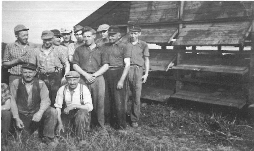
Arbeiter der Ziegelei Coldeborger Siel, um 1950
