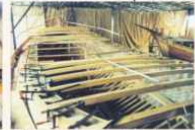
5. Legen der Decksbalken
