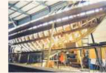
4. Anbringen der Beplankung
